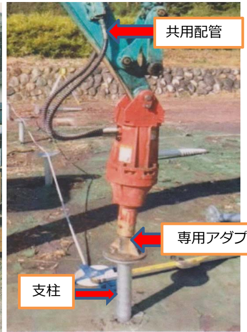
ソーラーパネル架台杭打ち
